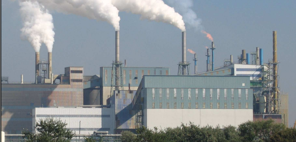
Thermal Phosphorus plant, Vlissingen, NL
