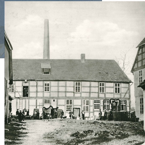
Erste Arbeitsstätte der Firma E. de Haën 1861
